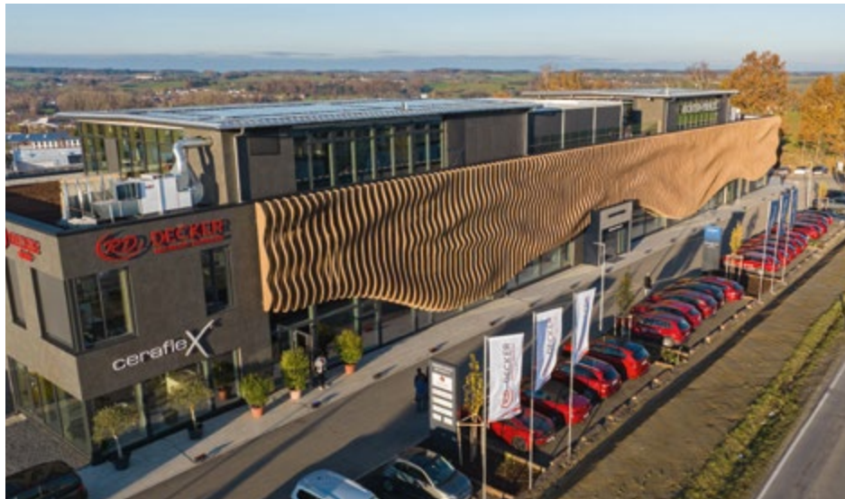
Decker Group-Zentrale in Dorfen - Gebäude errichtet in Holzmassivbauweise
